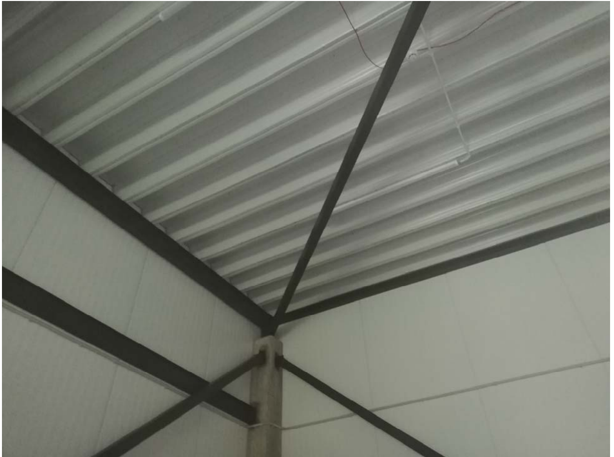
07 pav. Nagrinėjamo statinio IP1/b stogo konstrukcijų fotofiksacija
