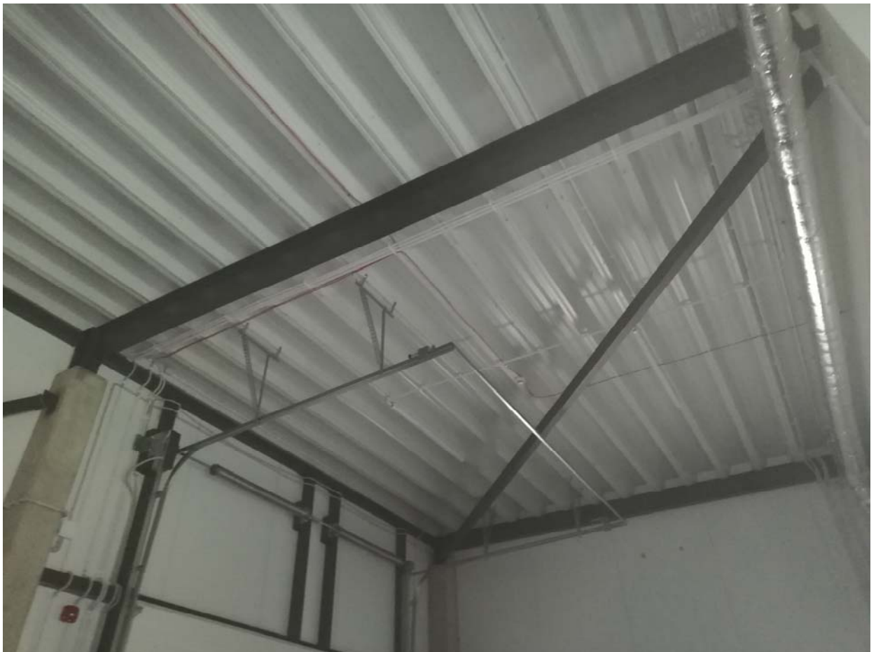
08 pav. Nagrinėjamo statinio IP1/b stogo konstrukcijų fotofiksacija
